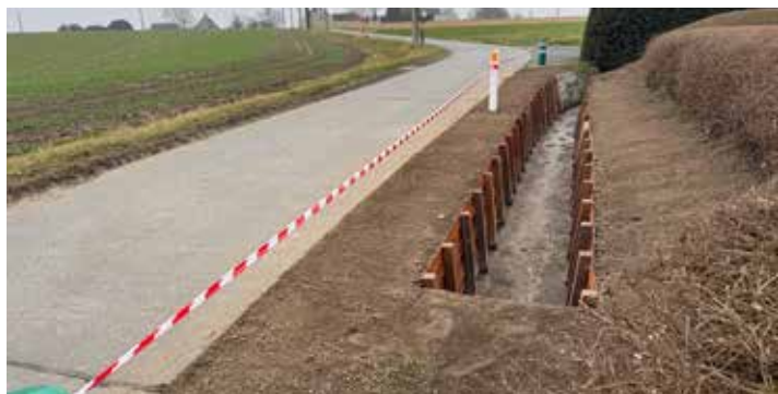
Verstevigen van een weggespoelde gracht in de Pareelstraat
