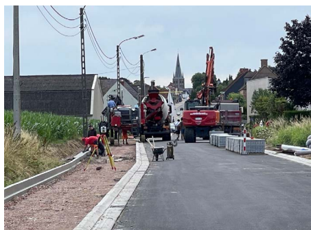
Ter hoogte van de Boeregemstraat wordt de buitenste rand van het fietspad aangelegd.
