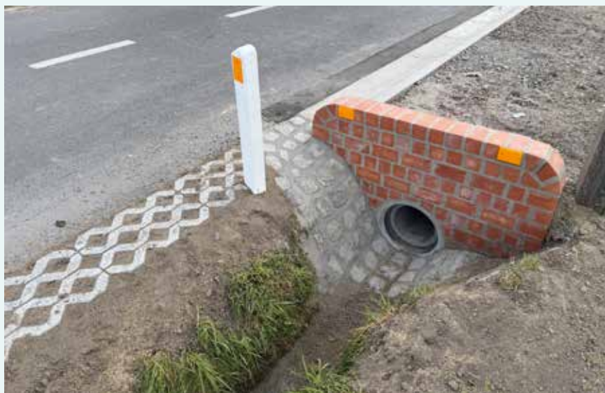
Plaatsen van greppels en borduren in de Biesbosstraat
