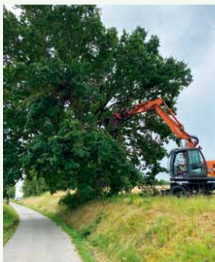
Opruimwerken na de storm van 19 juni 2026 (Diepestraat)
